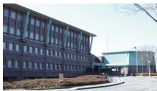
(写真左側が管理研修棟、右側が講堂)
